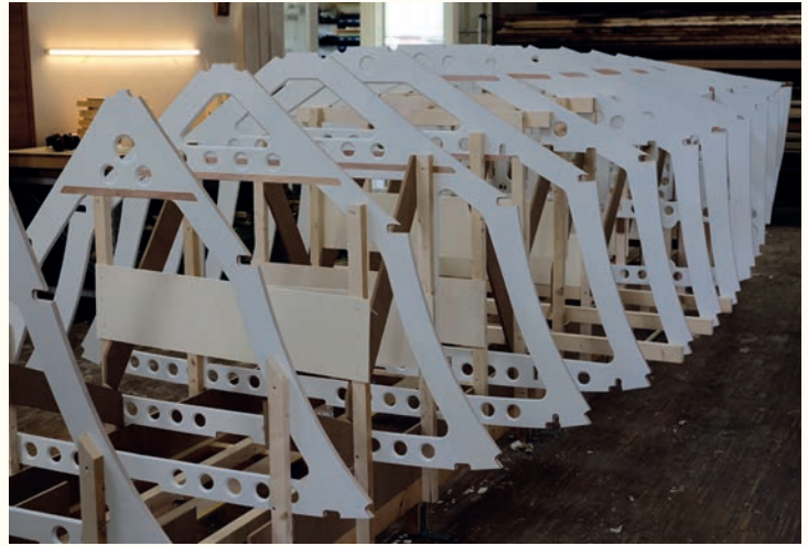
↑ Aufgestellte Bauteile; Foto: Juliane Hempel
